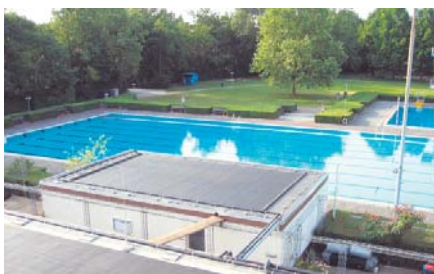
Solaranlage Freibad Egelsbach, Deutschland
