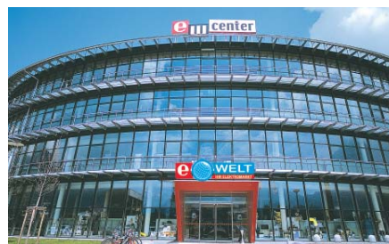
Firmenzentrale in Reutte
